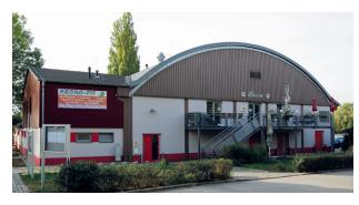
Nach dem Einbau von Seitenwänden erfolgt bis heute die Hauptnutzung als Sporthalle. Ein besonderer Blickfang ist das Hallendach mit der diagonal ausgebildeten sichtbaren Holzlamellenkonstruktion.
