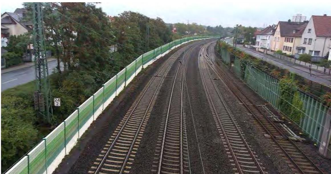
Foto: Beispiel für Lärmschutz entlang einer Haupteisenbahnstrecke
