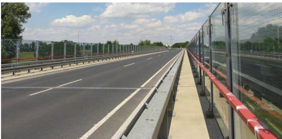
*Foto: Blick auf die Fahrbahn der Elbebrücke mit beidseitig installierten Lärmschutzwänden*
