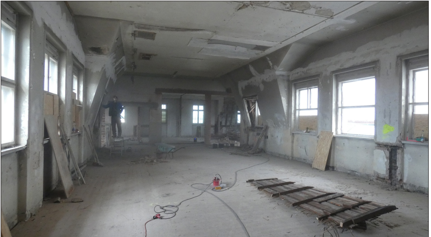
Blick in die Baustelle in der Alten Post
