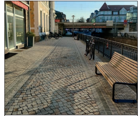
Ostseite fertig gestellt
