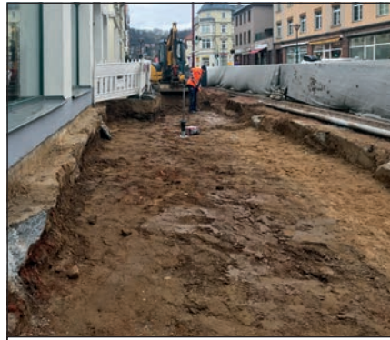
Westseite im Bau
