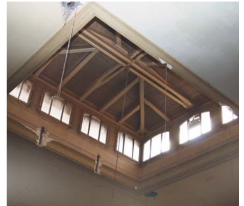
freigelegte Laterne über der Bahnhofshalle
