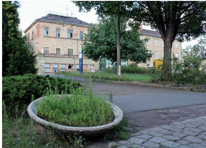
Der Höhenunterschied zwischen Sidonienstraße und Bahnhofsgelände ist ein besonderer Problempunkt.
