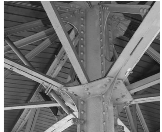
Die Säulen bestehen aus vier Teilen, die genietet wurden.
