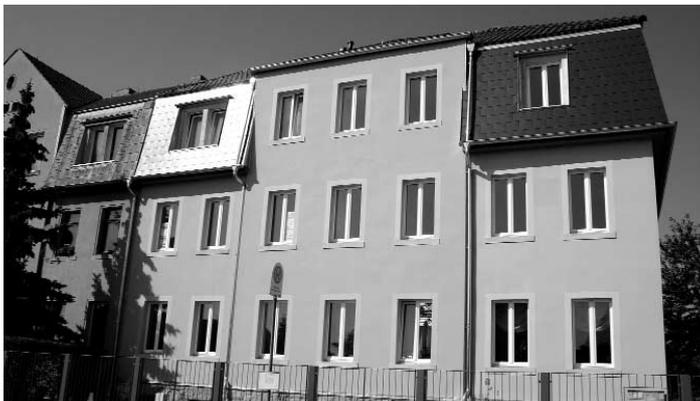
Serkowitzer Straße 5: Die Sanierungsarbeiten an diesem Gebäude, welches der Besitzgesellschaft Radebeul gehört, wurden im September 2006 abgeschlossen. Nötig waren die Instandsetzung des Dachs, der Fassade, Fenster und Türen sowie der Einfriedung.
