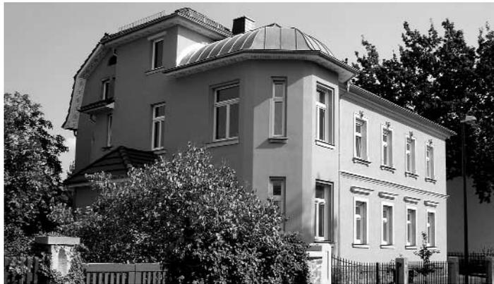
Wichernstraße 4: Dieses Schmuckstück mit seiner besonderen Architektur wurde im September dieses Jahres nach rund zweieinhalbjähriger Sanierung fertiggestellt. Die Fördermittel aus den Sanierungsgeldern wurden für Dachdecker- und Dachklempnerarbeiten, die Fassadeninstandsetzung sowie die Einfriedung verwendet.
