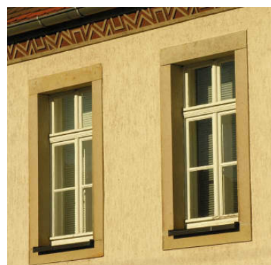
Sechsteilige Fenster mit festem, waagerechten Kämpfer; aufwändig verzierter Traufsims
