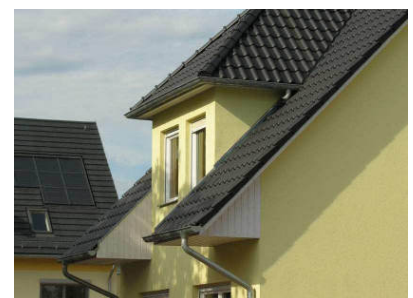
Zu weiter Dachüberstand, großer Dachkasten, unterbrochene Traufe
