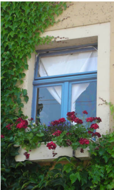
Dreiflügeliges Holzfenster "Galgen", stehendes Format mit Putzfaschen
