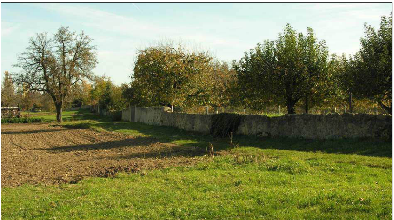
Bruchsteinmauern grenzen die Grundstücke nach hinten zur Landschaft ab
