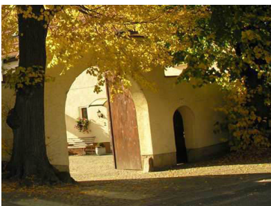
Tor- und Türöffnung mit Rundbögen
