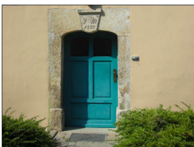
Sanierung einer Tür mit Gewände
