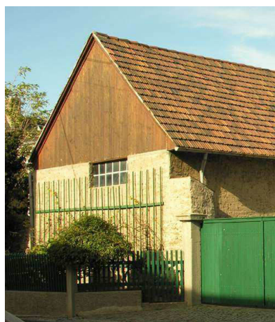
Gut im Detail: holzverkleidetes Giebeldreieck, Spalier
