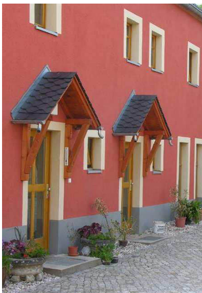
Zu stark abgesetzter Sockel, Faschen umlaufen nicht die Fenster
