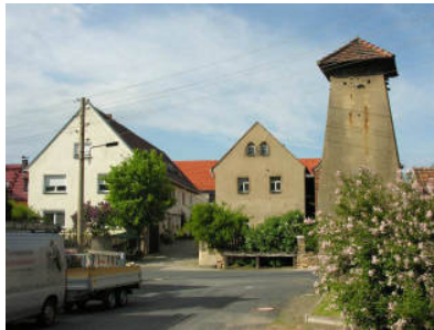
Turm in der Ortsmitte: dient(e) als Umspannstation / Halterung für Stromkabel
