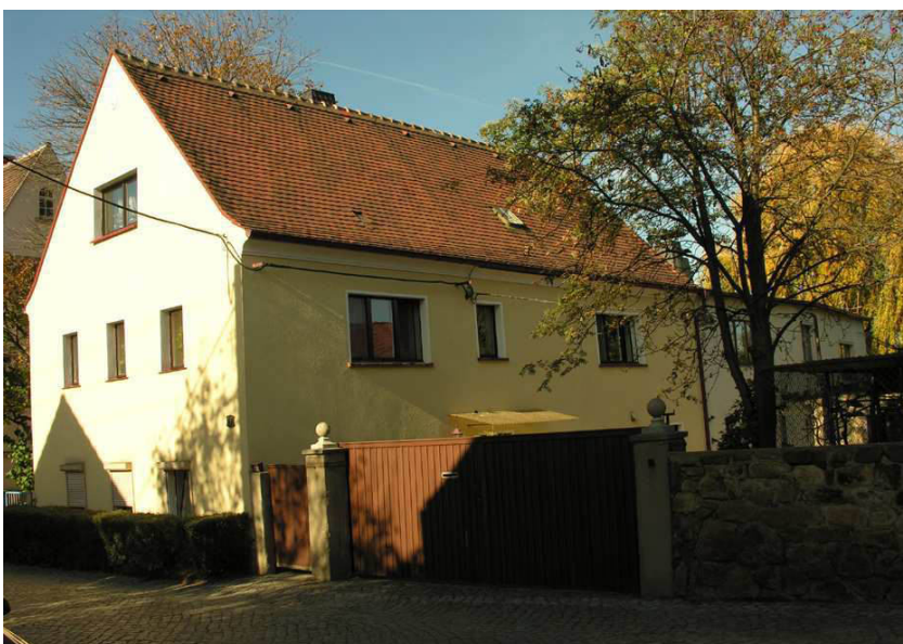
Sparrendach mit Aufschiebling und Traufgesims
