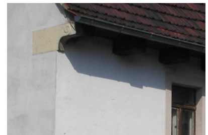
Sparrendach mit sichtbaren Balkenköpfen und verziertem Abschlussstein am Traufpunkt
