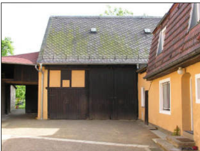
Scheune mit dem Hauptgebäude über weiteres Nebengebäude verbunden; unterschiedlich große, aufeinander abgestimmte Schiebetore
