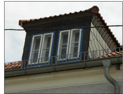
Schleppgauben sind möglich Schiefer steht im Kontrast zum roten Biberschwanz, wodurch die Gaube sehr schwer wirkt
