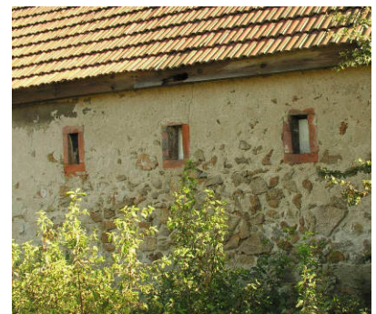
Nebengebäude: Fensteröffnungen mit Ziegelsteingewänden
