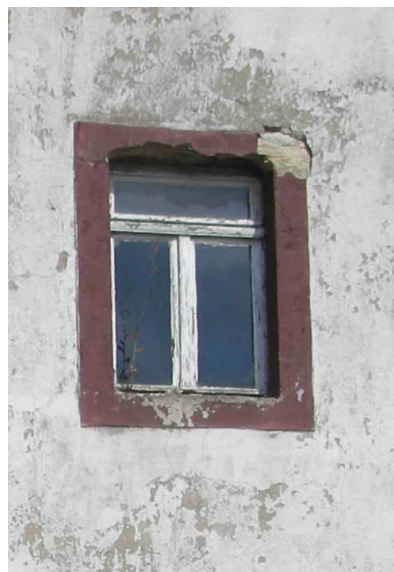
Älteres Beispiel für eine aufgemalte Fasche (Gewände überstrichen)
