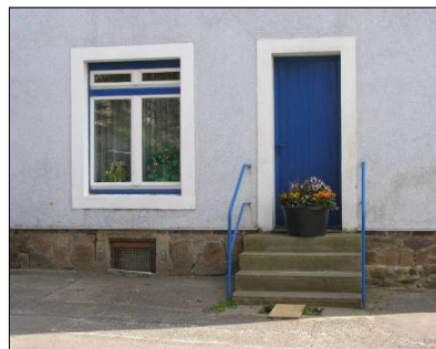
Erhaben aufgetputzte Putzfaschen
