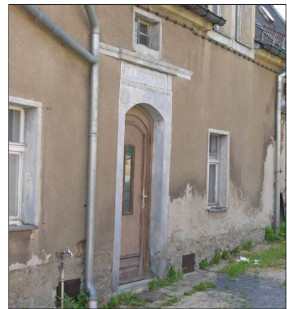
Betonung der Türachse durch ein zusätzliches Türgesims in Sandstein
