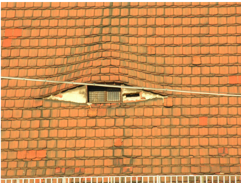
Traditionelle Fledermausgaube: klein und niedrig, fügt sich ohne Unterbrechung der Ziegelreihen in die Dachfläche ein
