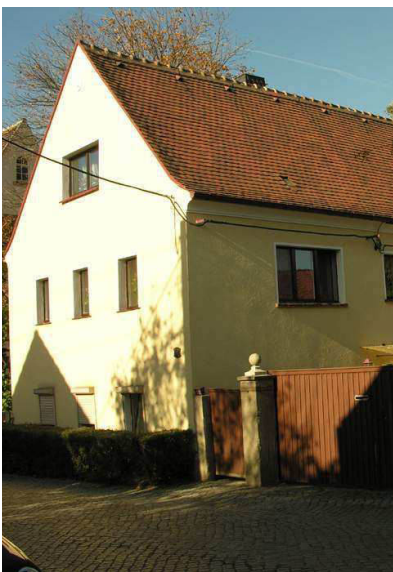
Traufgesims an der Längswand
