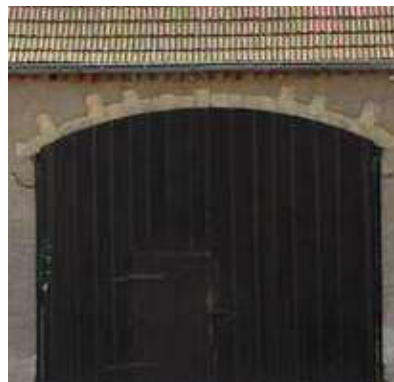
Sichtbare Natursteine im Segmentbogen über einem Scheunentor
