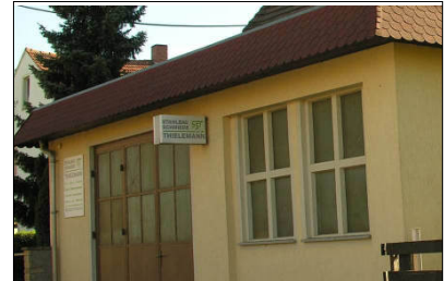
Innen beleuchteter Werbeträger an der Fassade
