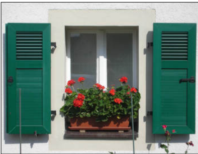
Zweiflügeliges Holzfenster in stehendem Format mit Putzfaschen und Fensterläden
