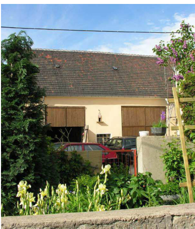
Markant: zwei große, symmetrisch an der Fassade angeordnete Tore
