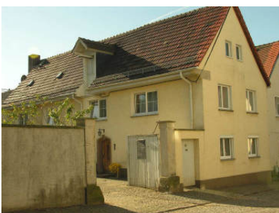
Betonung des Tores durch überhöhte Pfeiler, gerader Abschluss der Tür
