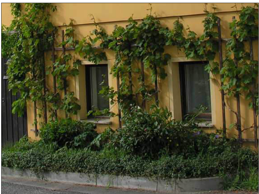
Auch ein sehr schmaler Vorbereich bietet ausreichend Platz für eine Fassadenbegrünung
