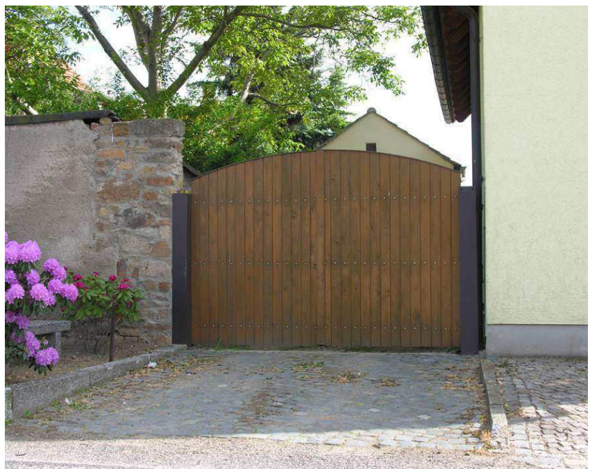
Hofeinfahrt richtungslos und wasserdurchlässig mit Natursteinpflastern belegt
