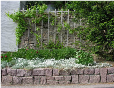
Bruchsteinmauer mit Spalier, davor begrünter Natursteinsockel
