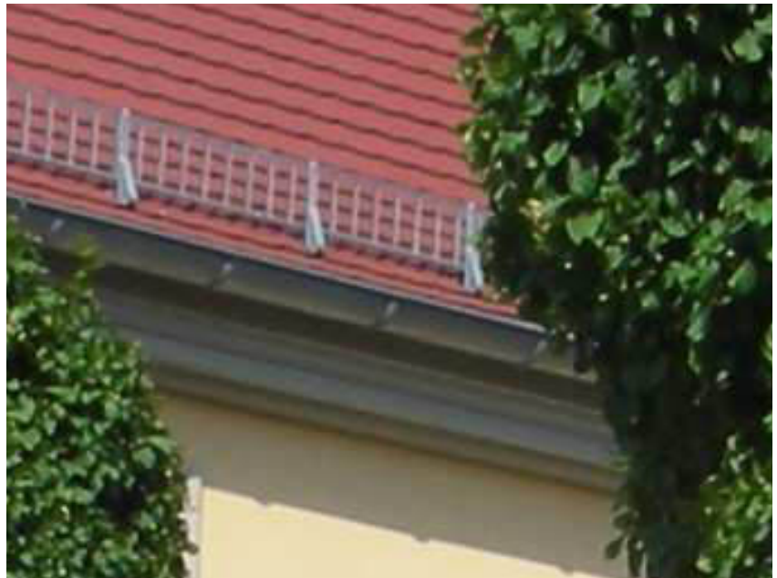
Traufpunkt beim Sparrendach mit profiliertem Traufgesims
