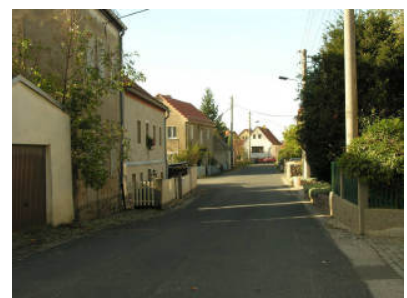
Im Anger von Wahnsdorf stehen Hauptgebäude traufständig zur Straße
