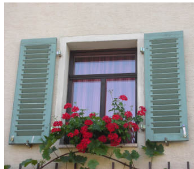
Beispiel für neue Fensterläden bei der Sanierung eines Gebäudes
