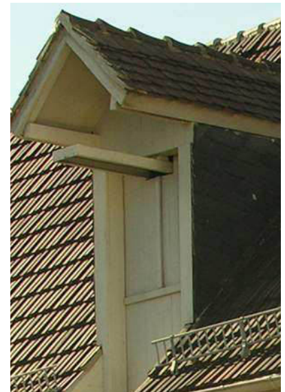
Holzläden an einem historischen Dachhäuschen
