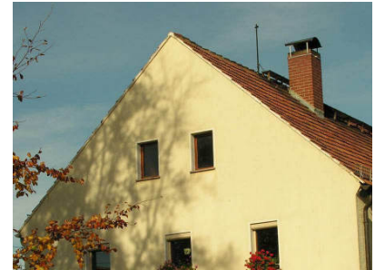
Ortgang mit geringem Überstand und am Rand vermörtelten Ziegeln
