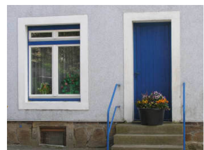
Ehemaliges Geschäft: vom Straßenraum erschlossen
