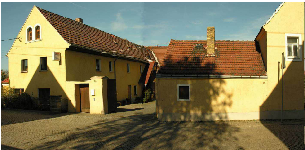
Beispiel für homogen gestaltetes Dach mit geringem Überstand an Traufe und Ortgang, Aufschiebling und gemauertem Dachgesims; die roten Biberschwanzziegel harmonieren mit der Fassade
