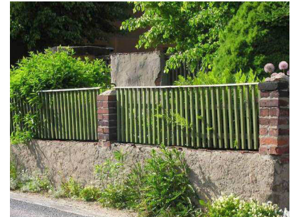
Pfosten mit Klinkern (Holzzaun und Begrünung passen)
