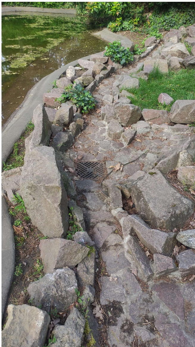
Zusammenführung der fünf Rinnen und Ablauf mit Rost
