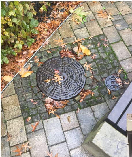
2) Wasserzählerschacht
