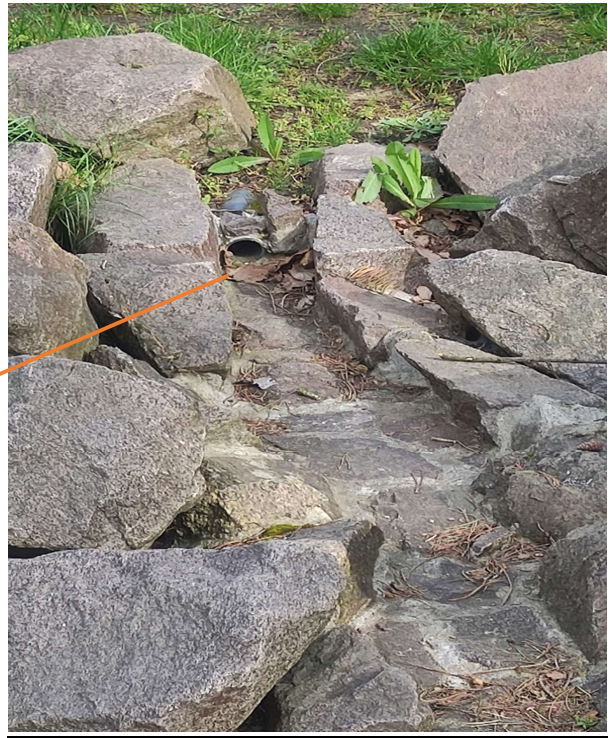
Beispiel Wasserauslauf Oberhalb
