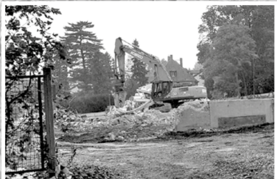
Abbruch Plattenbauschule Augustusweg 58
