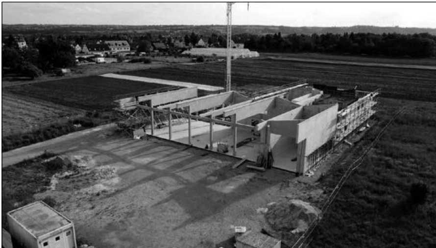
Blick in die zukünftige Fahrzeug- und Waschkabine
