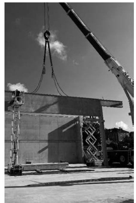
Einsetzen des ersten Betonfertigteils
