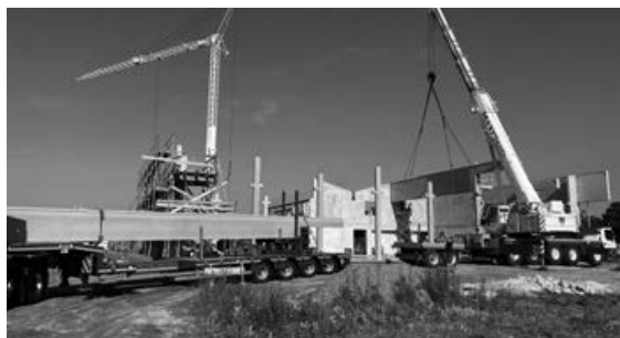
Anlieferung der Betonfertigteile
