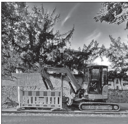
Oberlößnitz Straßen- und Kanalbaumaßnahme Augustusweg: Vorbereitende Arbeiten zur Erkundung der Medienlage
