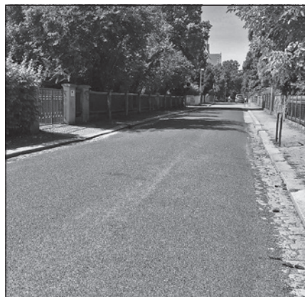
Radebeul Instandsetzung der zerschlissenen Asphalt- befestigungen auf der Steinbachstraße und Pestalozzistraße durch Oberflächenbehandlungen
