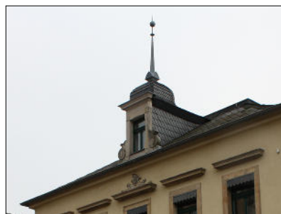
Harmoniestraße 9: Villenartiges Wohnhaus mit Lukarne und kleiner Haube, Schiefereindeckung
