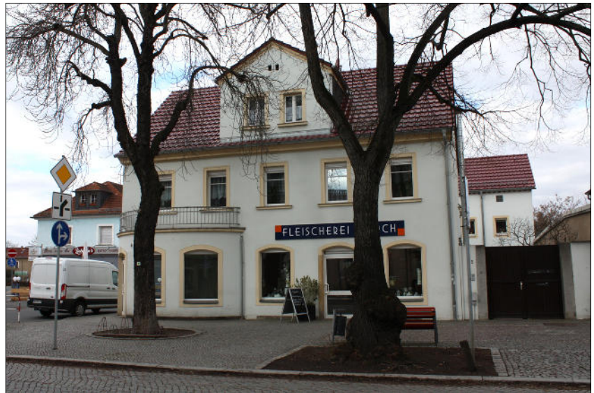
Bahnhofstraße 5: Putzfassade, Erd- und Obergeschoss sind in Material und Farbe gleich behandelt und nicht abgesetzt (kein Gurtgesims)
