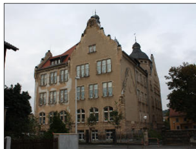
Harmoniestraße 7: 1904 errichtetes Schulgebäude
