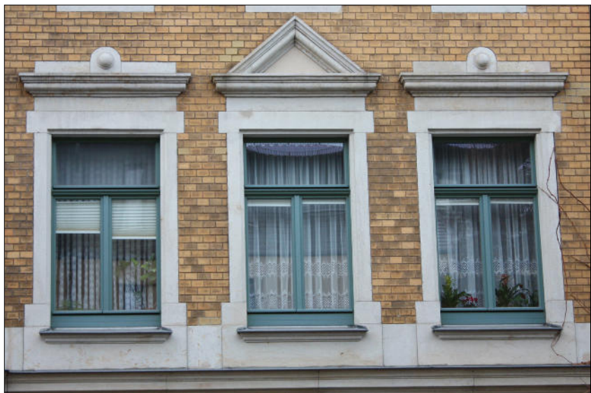
Bahnhofstraße 8: Das Galgenfenster (das zweiflügelige Fenster mit ungeteiltem Oberlicht) ist die typische Fensterteilung der Gründerzeit; mit Gewänden und auswändigen Verdachungen über den Fensteröffnungen
