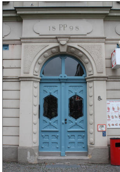
Bahnhofstraße 8a: Gründerzeitliche Tür mit Oberlicht, Rundbogen und Portal
