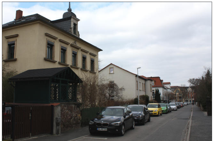
Harmoniestraße mit zweigeschossigen Wohnhäusern in offener Bauweise und mit begrünten Vorgärten
