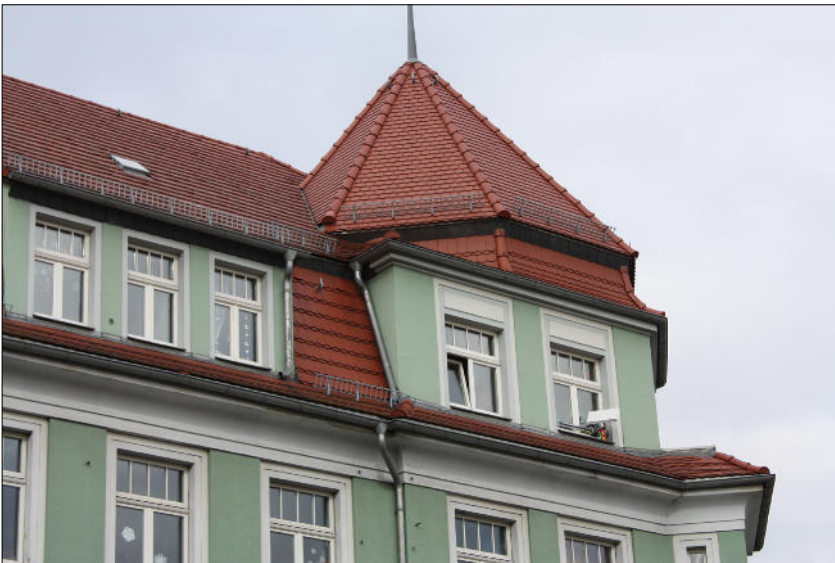
Güterhofstraße 1: Mansarddach mit Ziegeldeckung (Hauptdach Biberschwanz in Kronendeckung) des 1912 errichteten Wohn- und Geschäftshauses mit Ecktürmchen und Schleppgaube
