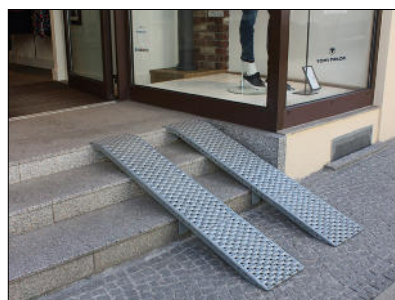
Beispiel einer mobilen Rampe zur Überbrückung nicht barrierefreier Zugänge
