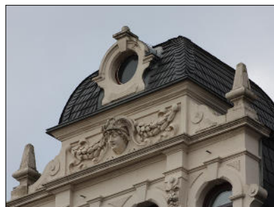
Bahnhofstraße 8a: Schiefergedeckter Dachaufbau
