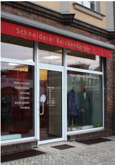
Bahnhofstraße 12: Dezentere Schriftzug an der Markise mangels Platz zwischen Schaufenster und Gurtgesims im Einzelfall sinnvoll
