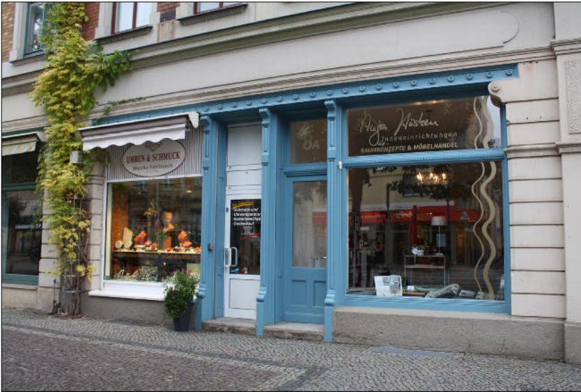
Bahnhofstraße 8a: Geschäfte in gründerzeitlichem Gebäude, rechts mit originaler Schaufenstergliederung, links "neuzeitlich" verändert
