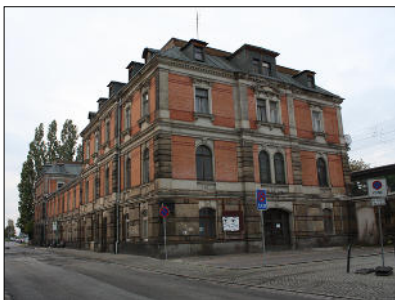
Bahnhofstraße 10: 1896 erbautes Empfangs- und Abfertigungsgebäude des Bahnhofs
