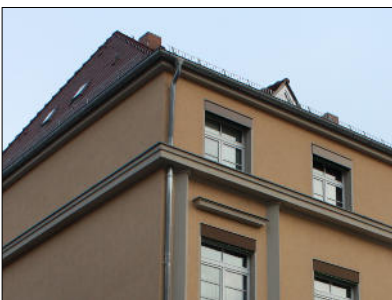
Bahnhofstraße 12: Starkes Traufgesims zwischen Dachgeschoss und darunterliegendem Geschoss
