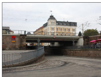
Unterführung der Bahnhofstraße unter der 2012 neu errichteten Eisenbahnbrücke
