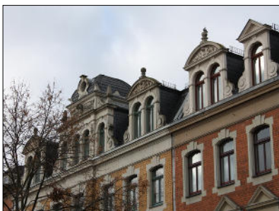
Bahnhofstraße 8 und 8a: Üppige historisierende Dachaufbauten im Stil des Barock
