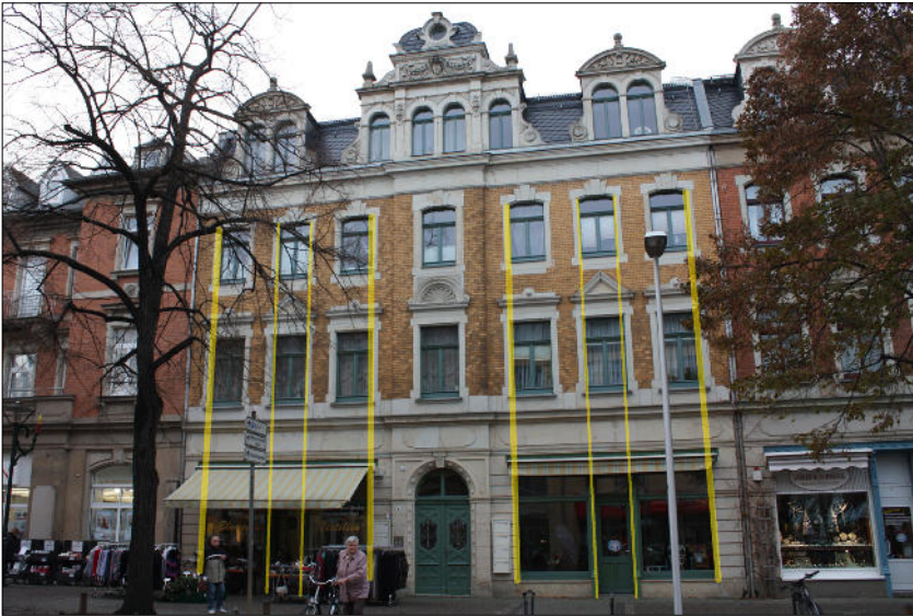
Klarer Bezug der Schaufenster auf die Obergeschossfenster (Bahnhofstraße 8)
