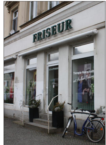
Meißner Straße 266: Schriftzug zwischen dem Schaufenster des Erdgeschosses und dem Sohlbankgesims des Obergeschosses
