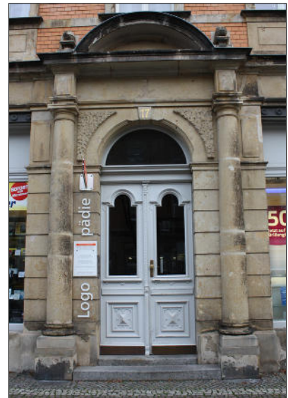
Bahnhofstraße 17: Tür mit Rundbogen, Portal zur Betonung des Eingangs
