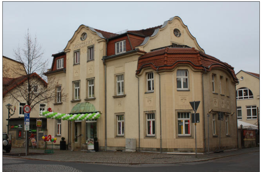
Bahnhofstraße 19: Lochfassade mit überwiegendem Wandanteil und klarer Fassadengliederung (Mittelrisalit mit Zwerchgiebel, Lage der Fenster auf senkrechten Achsen)
