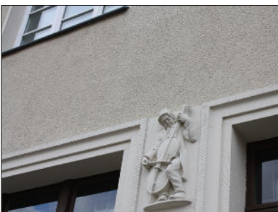
Bahnhofstraße 20: Putzfassade mit Relief zwischen den erdgeschossigen Fenstern
