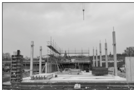
Blick in die zukünftige Fahrzeughalle mit den 6 Stellplätzen
