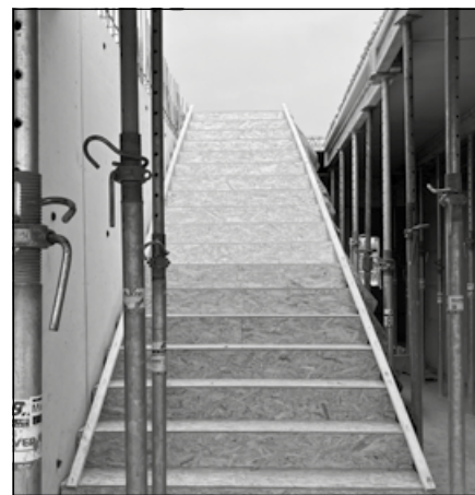
Eingangsbereich mit Treppe ins Obergeschoss
